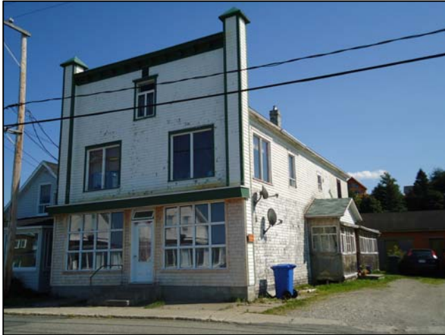
Figure 68. Un bâtiment commercial à façade postiche ou Boom Town, Saint-Ulric, DSC01069
