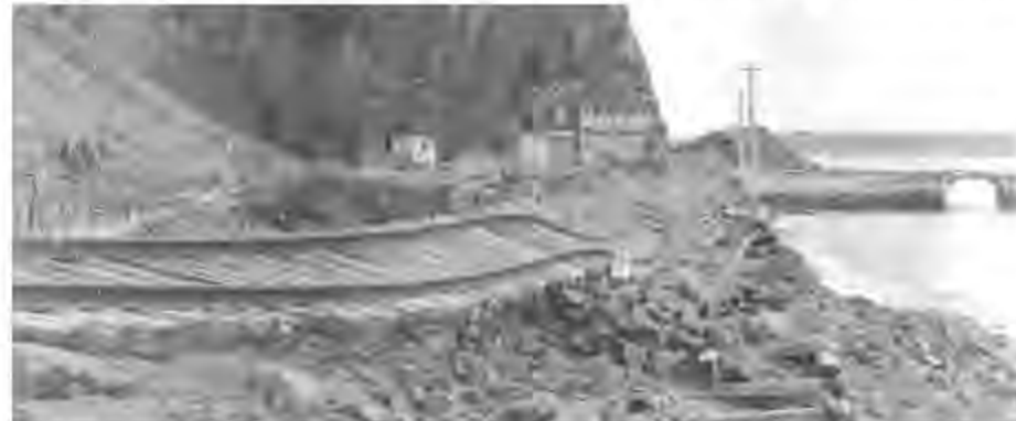
Domages causés par le tremblement de terre, près du vieux quai de Baie-Saint-Paul Photo Ernest-A. Hodgson, Commission géologique du Canada
