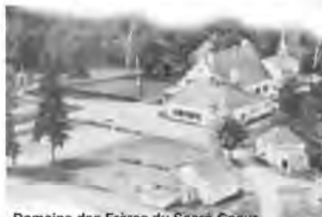
Domaine des Frères du Sacré-Coeur Les Éboulements
