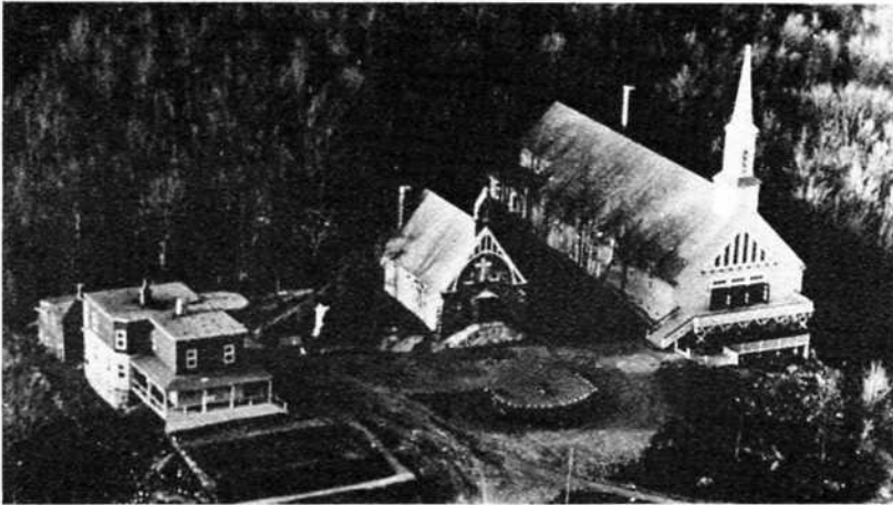
Sanctuaire en état d'abandon
